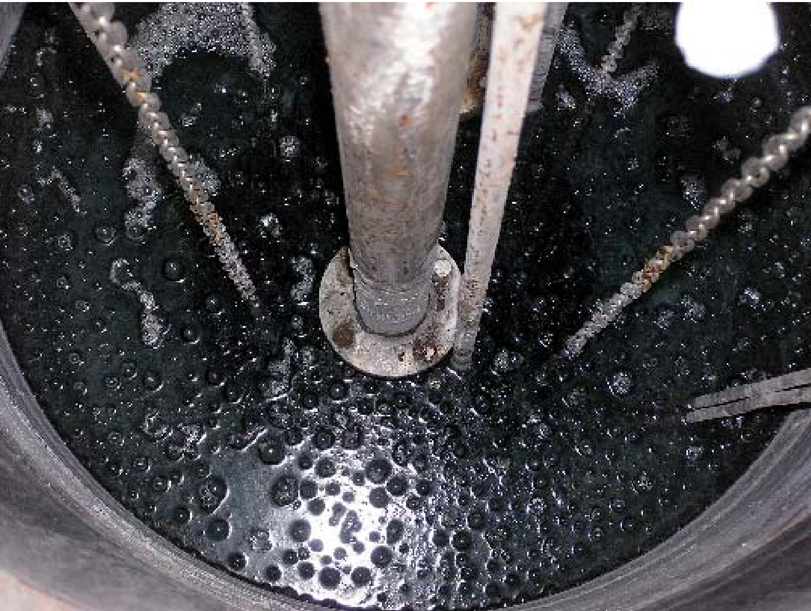
Kaiserquelle mit eingesenkter Pumpe
